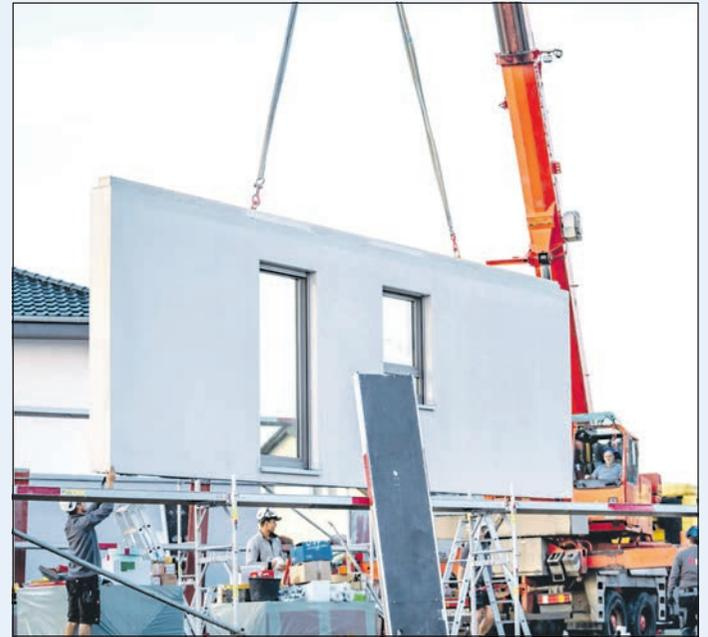
Die Ausbauhäuser werden industriell vorgefertigt, der Rohbau steht innerhalb von zwei Tagen. Die Wandelemente werden im Werk unter kontrollierten Bedingungen hergestellt und auf der Baustelle montiert.
