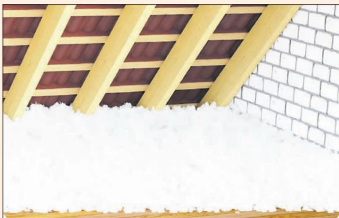
**txn.** Geringer Aufwand, großer Effekt: Einblasdämmungen aus Mineralwolle lassen sich vielseitig einsetzen – beispielsweise für die Dämmung der obersten Geschossdecke bei nicht ausgebauten Steildächern.
