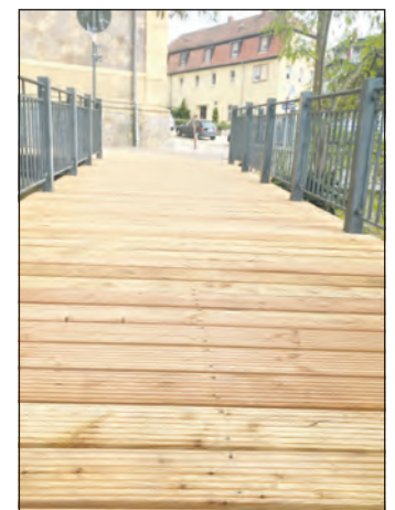
Der Artur-Grosse-Weg erhielt eine neue Holzbeplankung.
