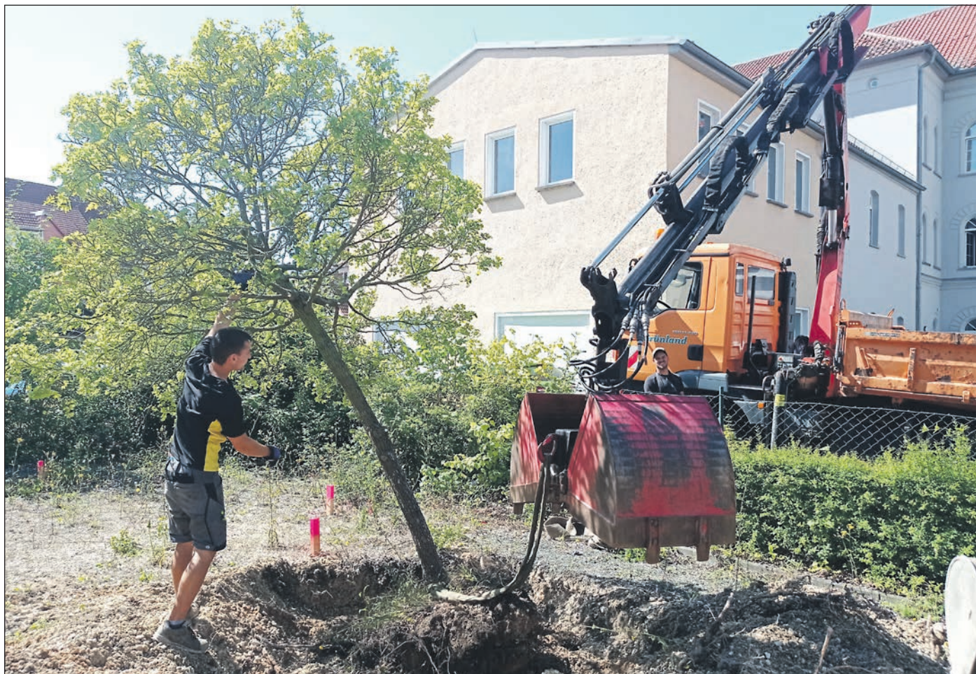
Anlegen eines Schutzgurtes am Baumstamm und vorsichtiges Lösen des Wurzelballens nach vorheriger Freilage.
