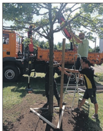
Anbringung eines Dreibecks zur Standsicherung nach vorherigem gründlichen Wässern. Foto: LRA
