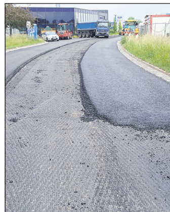
Der Einbau Asphaltbinder unter Asphaltdeckschicht.
