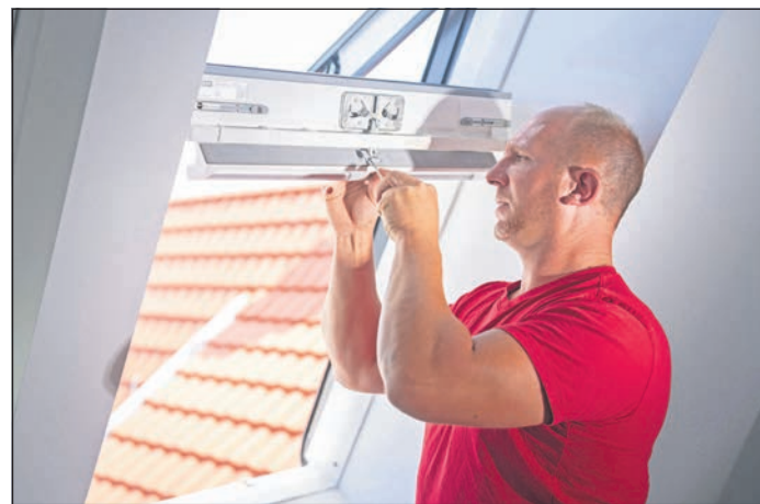
▲ Viele Probleme und Schäden rund um Dachfenster lassen sich durch eine Reparatur beheben. Das spart Zeit und vor allem Geld: Denn ein Ersatzteil ist günstiger und umweltfreundlicher als ein komplett neues Dachfenster. Foto: djd/TLS-Dachfenster
