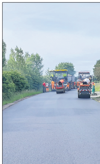
▲ Fahrbelag wird aufgetragen.
