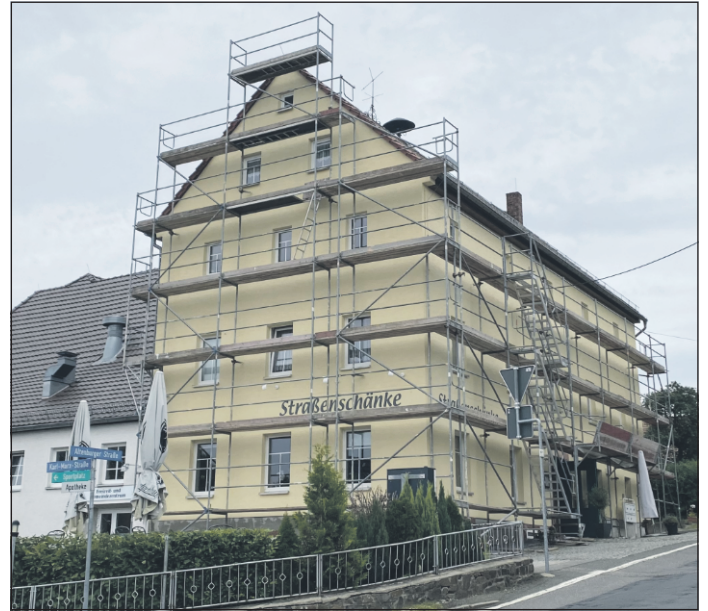
▲ Am Gemeindegebäude, in dem die Gaststätte „Straßenschänke“ eingemietet ist, konnte die West- und Südseite der Außenfassade saniert werden. Die Gesamtkosten belaufen sich auf circa 33.000 Euro, die über die Dorferneuerung durch das TLLLR gefördert wurden. Der Eigenanteil der Gemeinde beträgt circa 5.000 Euro.
