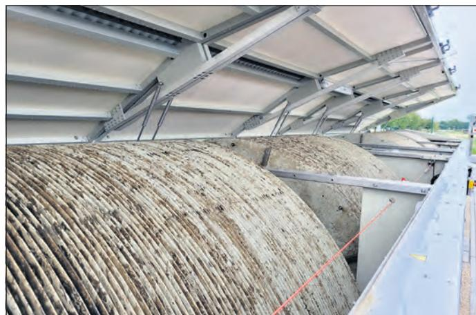
Die effektive Abwasserreinigung wird durch den Scheibentauchkörper unterstützt.
