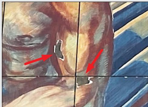
Durch massive Steinwurf-Geschosse wurden die Emaille-Platten beschädigt.
