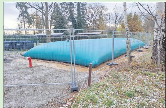
▲ Errichtung einer faltbaren Löschwasserzisterne im Ortsteil Panna, Alte Grube, in Fockendorf.
