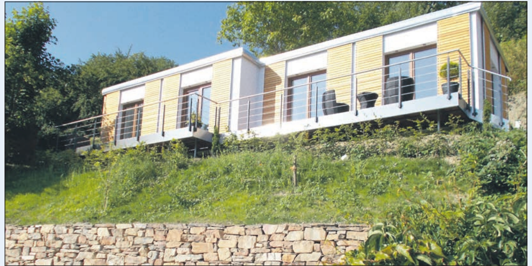
Auf dem Grundstück im bergischen Gelände sind die einzelnen Hausmodule etwas versetzt nebeneinander angeordnet. Foto: DJD/Smart House
