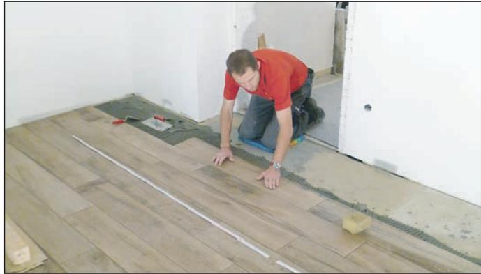
▲ Längliche Fliesen in Holzoptik liegen voll im Trend, die Voraussetzung für die Verlegung ist ein ebener, fester Untergrund, etwa aus Trockenestrich-Elementen. Foto: fermacell/txn
