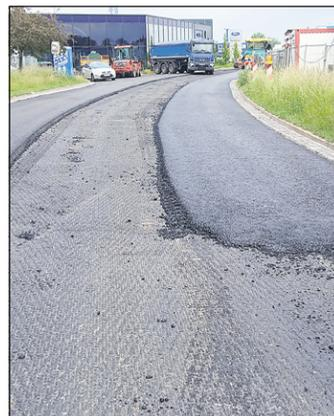
Der Einbau Asphaltbinder unter Asphaltdeckschicht.
