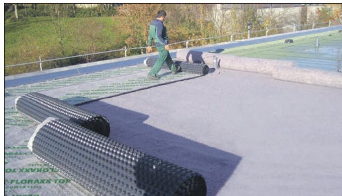
▲ *Damit eine Dachbegrünung dauerhaft funktioniert, kommt es auf das Drainagesystem an. Spezielle Noppenbahnen mit aufkaschiertem Filtervlies verhindern Staunässe und speichern gleichzeitig Regenwasser.*
