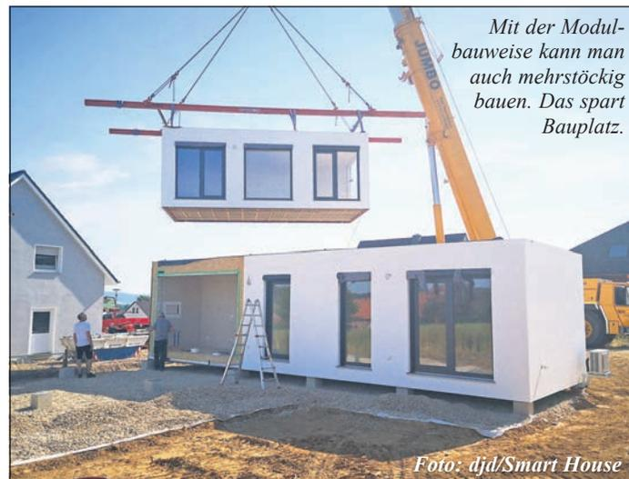
Mit der Modulbauweise kann man auch mehrstöckig bauen. Das spart Bauplatz.
